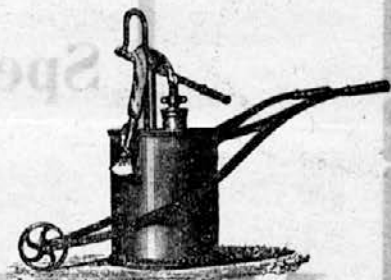
Vozna brenna točna brizgalnica, jednostavno brizgajoča
