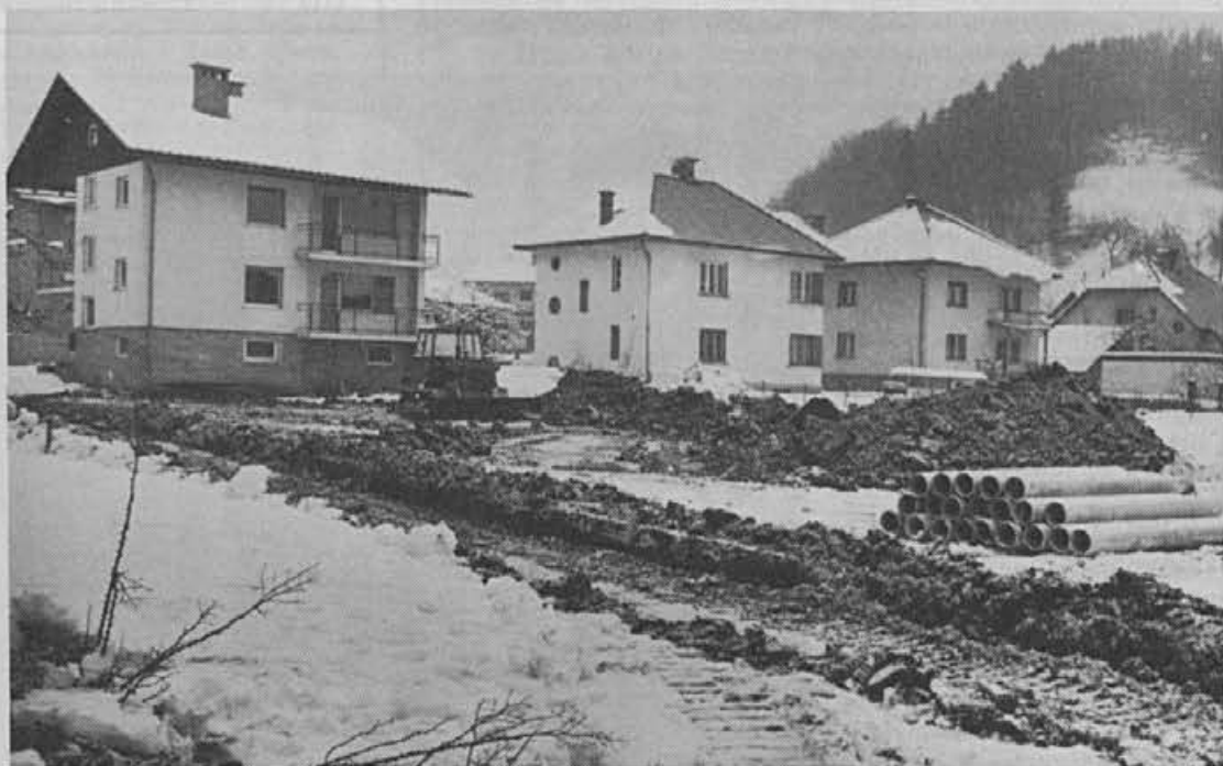
Gradnja kanalizacije v Žireh se je že pričela
