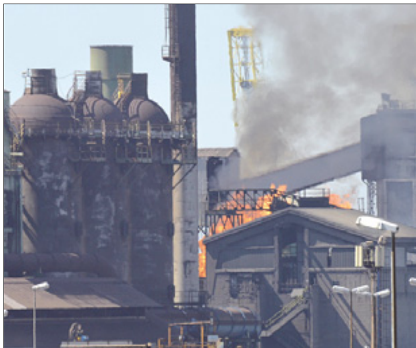
Pogled na škedenjsko železarno
