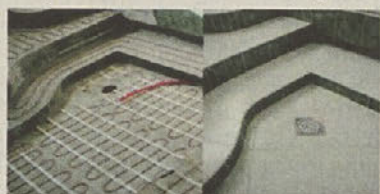
Položena keramika na grelnih kablích
