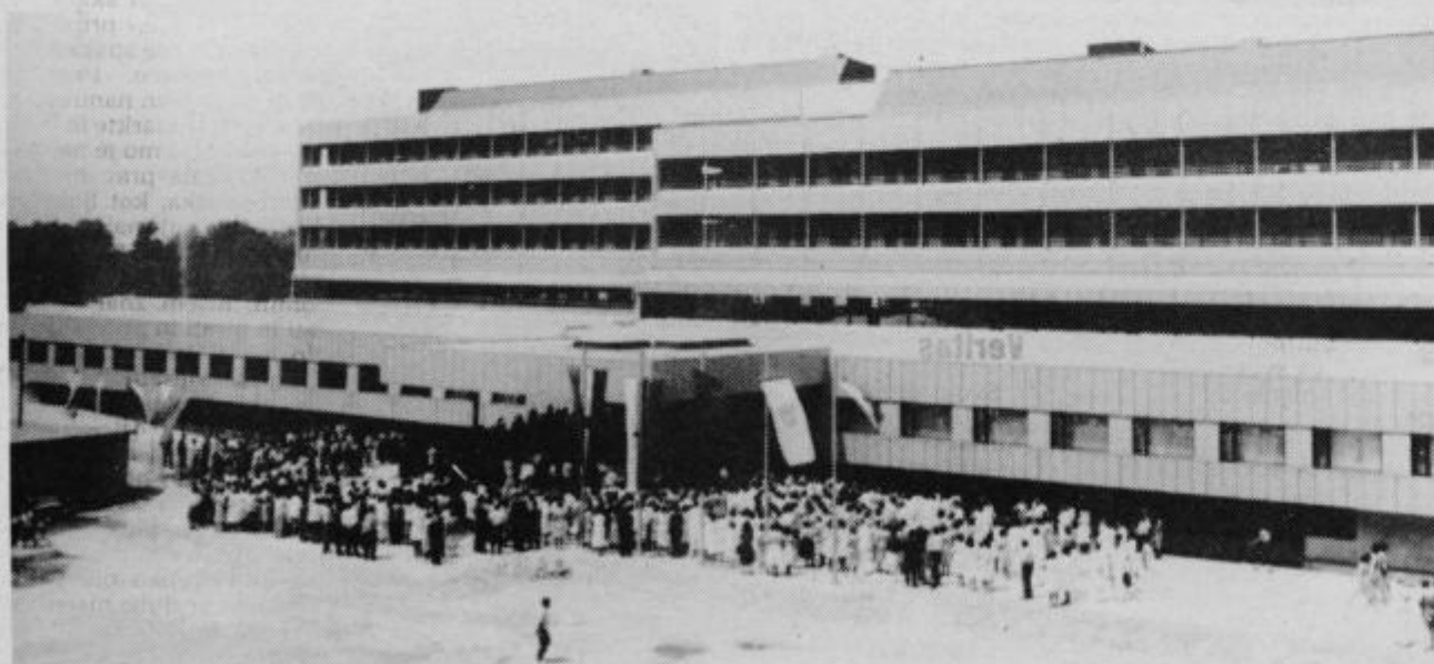
Specialistično ambulantno dejavnost so vse do leta 1986 opravljali v kletnih prostorih bolnišnice. Danes jo v novem medicinskem objektu (posnetek je napravljen ob otvoritvi).
