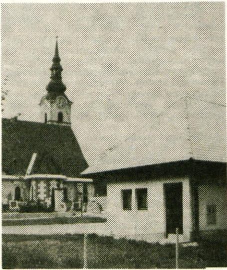
Med pokopališčem in vežicami bodo letos zgradili žarni zid...
