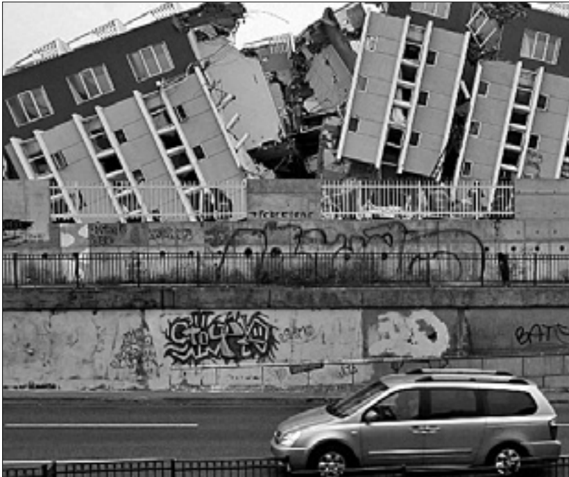
Uničena stanovanjska stavba v mestu Concepcion
