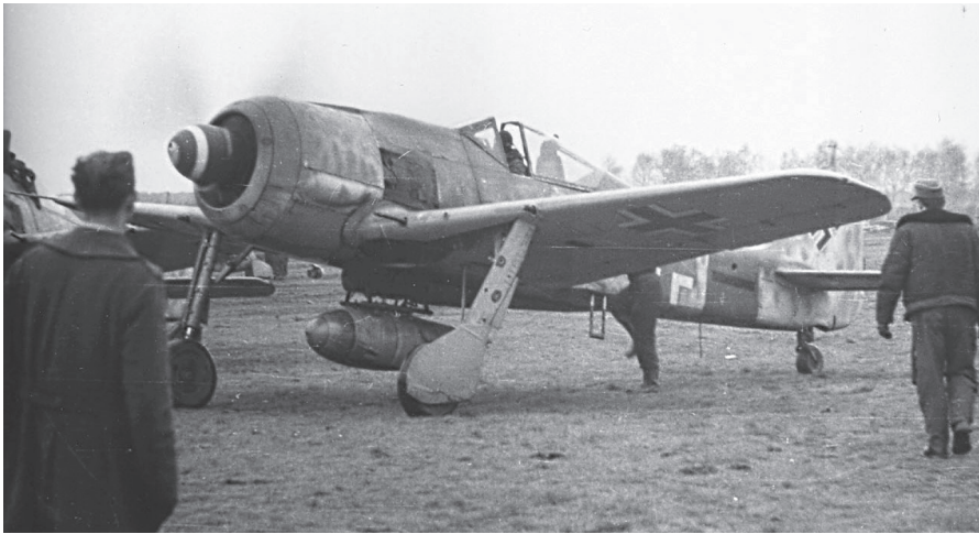
Podobno letalo iz iste enote (II./JG 300). Značilnosti Fw 190A-8/R2 – prekriti strojnici, kratkocevní trop MK 108 v krilu in dodatni oklep – so dobro vidne.
