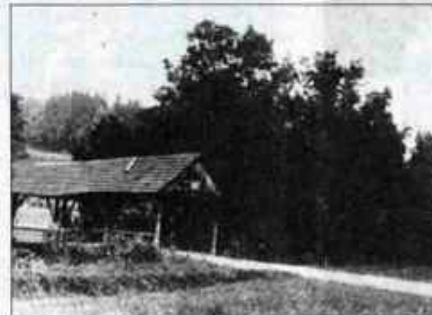
S streho pokriti most čez Soro na Ledinici, podrt 1981
