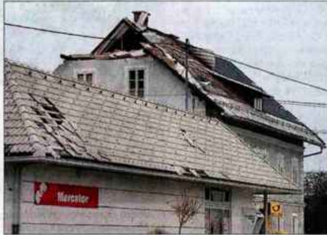
Streha nad pošto v Žirovnici.
