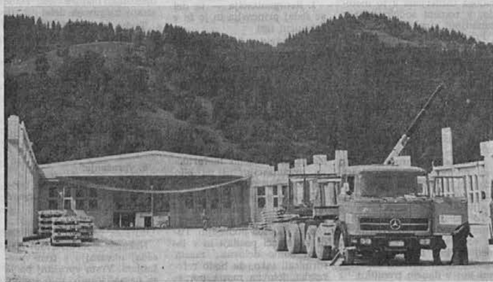
Gradnja nove hale lepo napreduje
