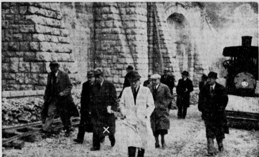
G. gradbeni minister Dobrivoje Stošovič (X) si v spremstvu strokovne komisije ogleduje velika gradbena dela za modernizacijo državne ceste na Gašpetskem klanecu pri Kranju.
