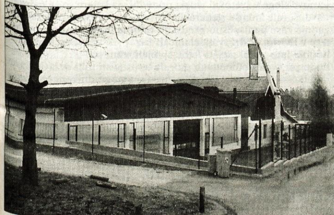
Nova proizvodna hala, s katero so pridobili 650 kvadratnih metrov proizvodnih površin, garderobo, dve pisarni ter dve veliki nepokriti skladišči. Na južni strani pa imajo hidravlično dvigalo za natovarjanje tovornjakov.
