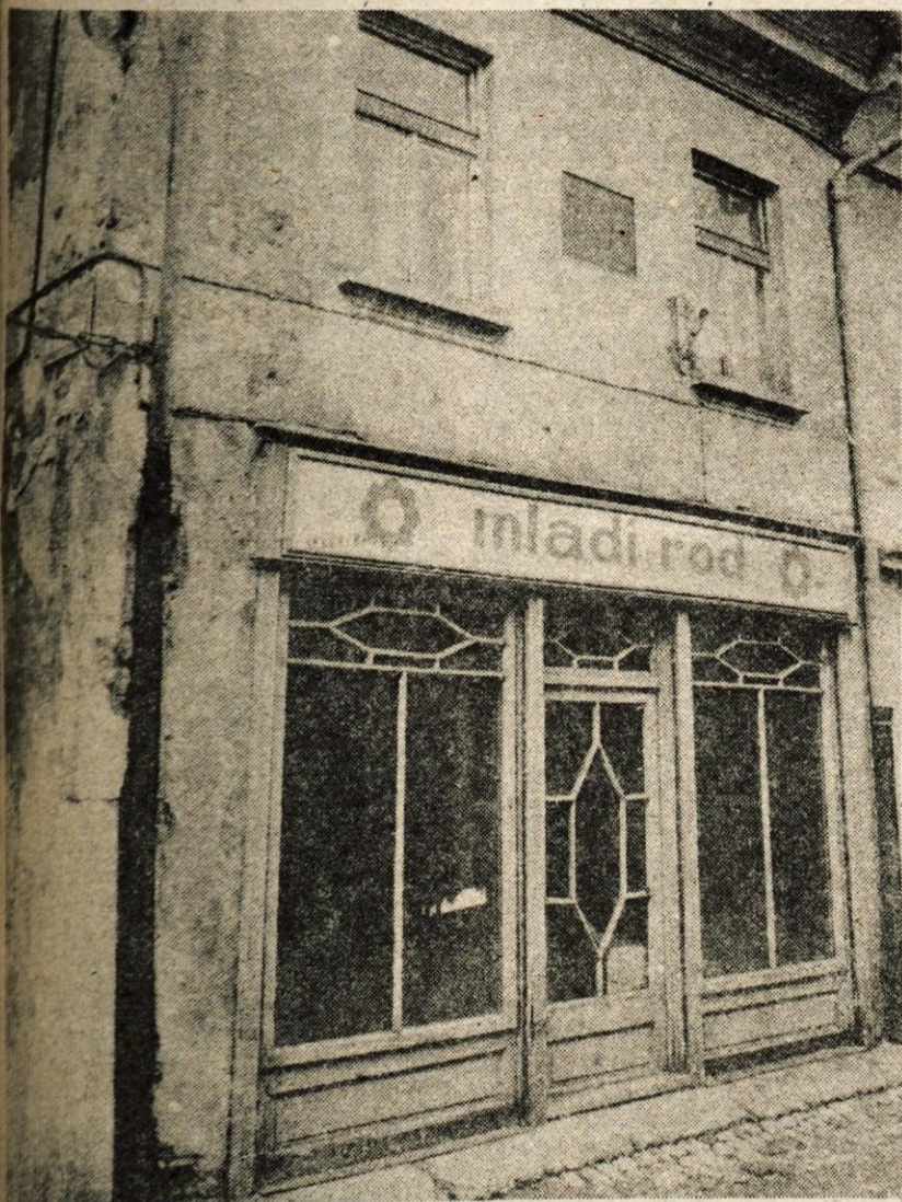
Zapuščena in zanemarjena Jenkova hiša — Recimo ji kar Jenkova hiša, čeprav takšnega imena res ne zasluži. Z zanemarjenim obrazom gleda v svet in zapuščen prodajalna propadlega Mladega roda še podčrtuje njeno propadanje. Le skromna spominska tabla na pročelju v prvem nadstropju pove, da je v tej hiši umrl slovenski pesnik Simon Jenko. Ker jo malokdo opazi, vam povemo, da so jo vzdali 2. septembra 1923 leta. Odtlej je torej minilo natančno šestdeset let, na hišo, v kateri je žalostno umrl veliki slovenski pesnik, pa ni spomnil nihče več. — M. Volčjak — Foto: F. Perdan
