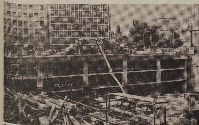
Betoniranje plošče druge faze gradnje Ploščadi Borisa Kraigherja
