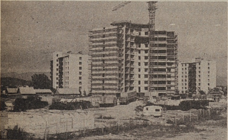
Gradnja stolpnice Y1 v Novih Jaršah
