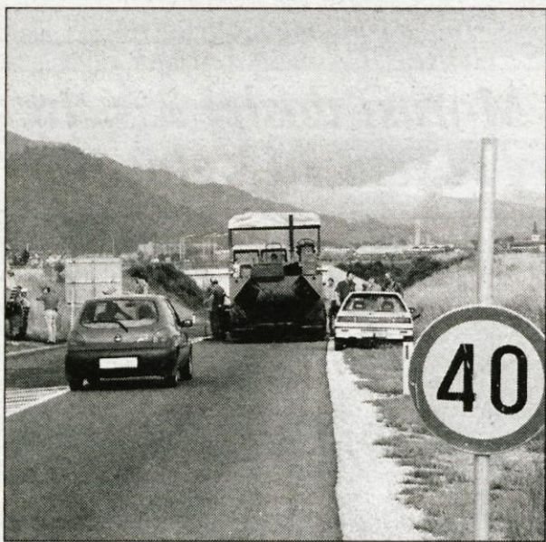
Odsek regionalne ceste Kranj-Brnik v bližini uvoza na avtocesto Kranj-vzhod so delavci Cestnega podjetja ta teden na novo preplastili. Na sploh je poletje in z njim prihajajoča turistična sezona spet pravi čas za različna bolj ali manj pomembna popravila in obnove cest, ki že tako ali tako gost in počasen promet še dodatno zadržujejo. • Foto: T. Dokl
