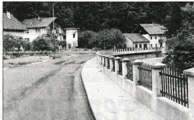
Država je po dveh letih obnovila malo načeto cesto v Železnikih.
