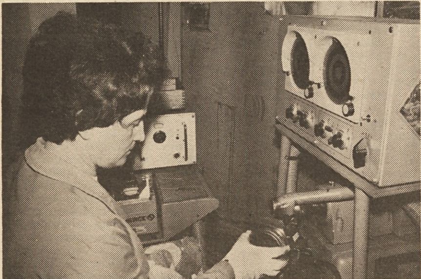
Ančka Deželak balansira motorje.
