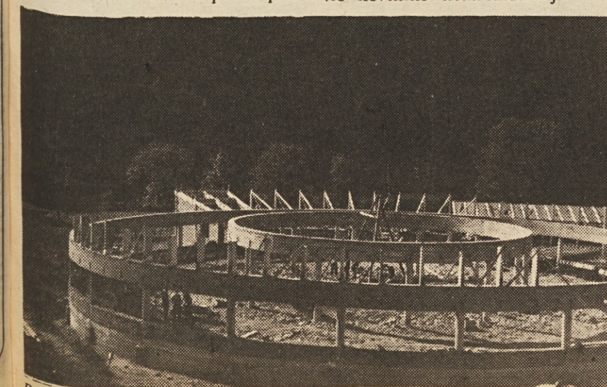
Današnja Iskra v Železnikih med gradnjo.
