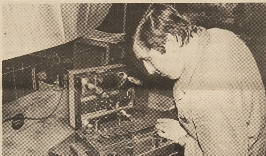
V proizvodnem programu TOZD Orodja na Stegnah v okviru Industrije za avtomatiko so tudi orodja, kakršno vidimo na sliki. To je kombinirano orodje za postopni rez, ki so ga tu izdelali za zahtevnega tujega kupca. Seveda pa lahko izdelujejo še druga, zamotana in zahtevna, saj imajo za to solidno strojno opremo in večje orodjarje, ki med drugim radi ustrezajo tudi z raznimi orodji za bakelit in druge plastične snovi, za brizgani liv, vse vrste rezilnih orodij in kombiniranih orodij, ki lahko zadovoljijo najzahtevnejšega naročnika. Na sliki: orodjar Marjan Nartnik preizkuša izdelano kombinirano orodje za postopni rez, na kakršna tuji naročnik že nestrno čaka.
