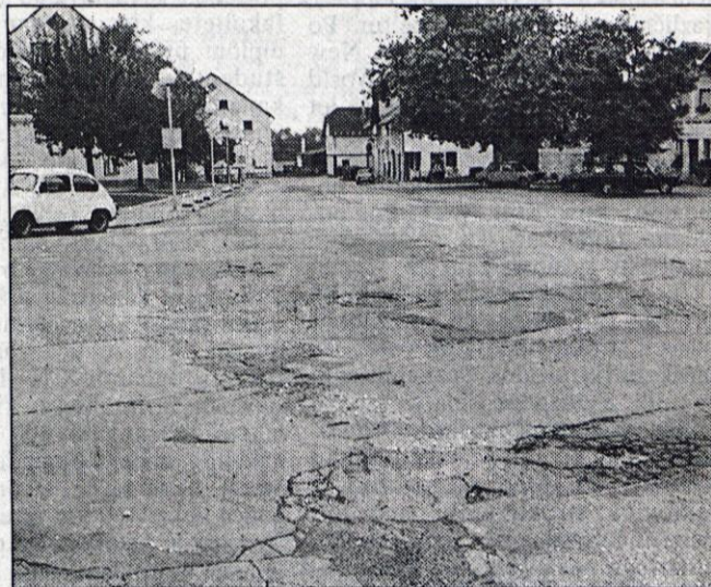
Luknje in zaplate, značilnosti ceste skozi Cerklje.
