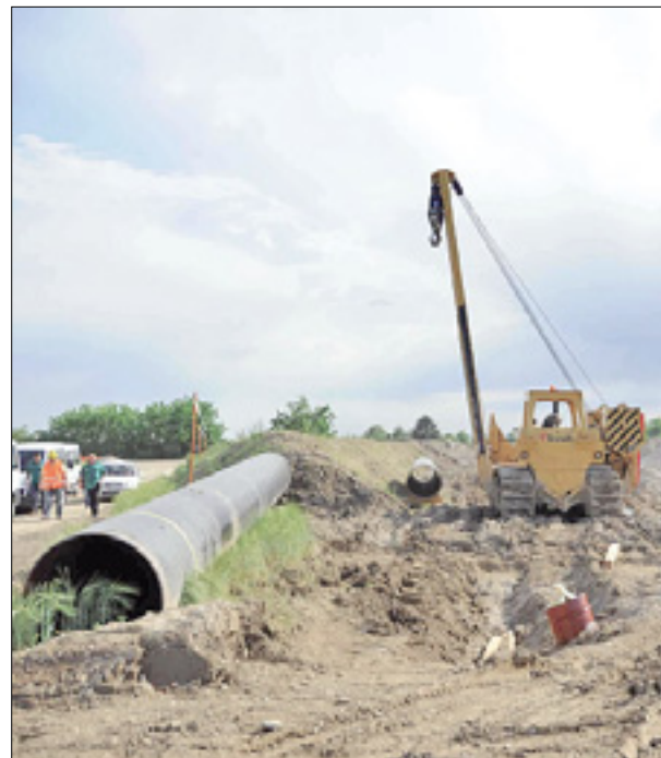
Premeščanje cevi plinovoda pri Vilešu
