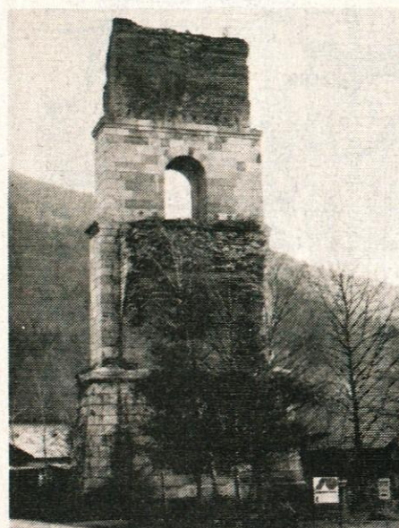
Steber borovniškega viadukta
