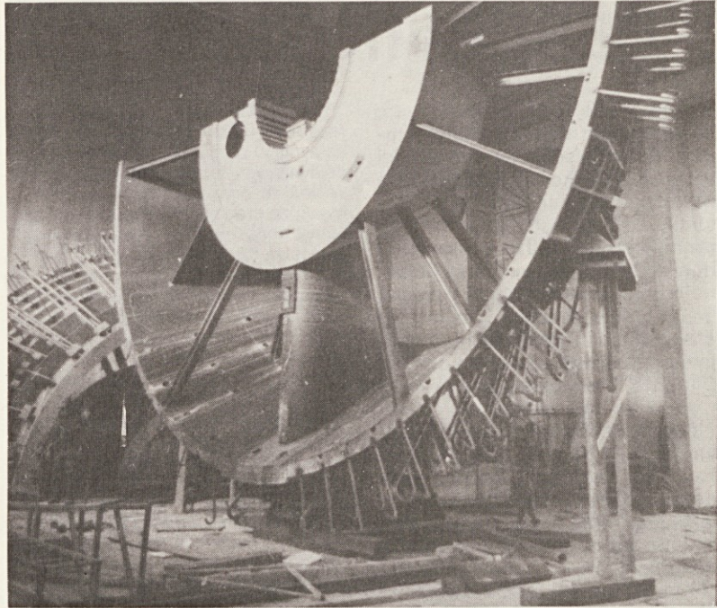
Predvodilnik pred vgraditvijo v HE Čakovec (leta 1980)
