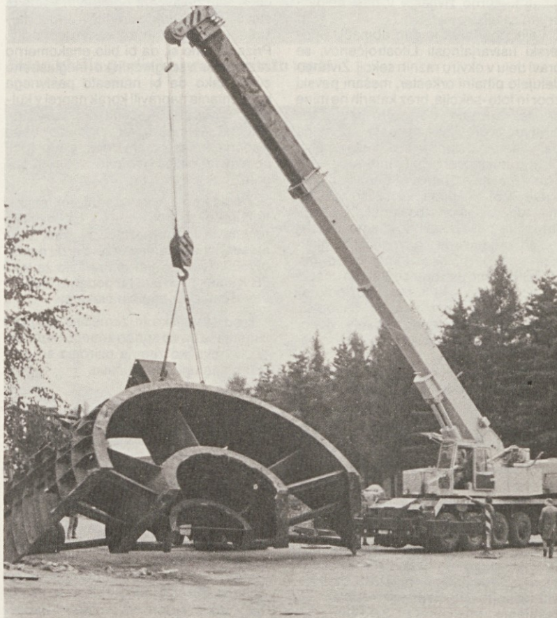
Fantje iz Montaže so se precej namučili preden so polovico predvodilnika za HE Dubravo spravili v pločevinarno. Mogoče pa je takšna 55-tonska gmeta jekla le prevelik zalogaj za naše avtodvigalo. (Foto: E. L.)
