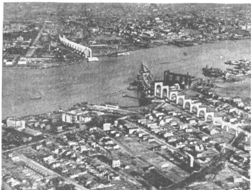
Nosilci za dovozne klančine k Hudsonskemu mostu, ki so jih sezidali, preden so začeli graditi most sam
