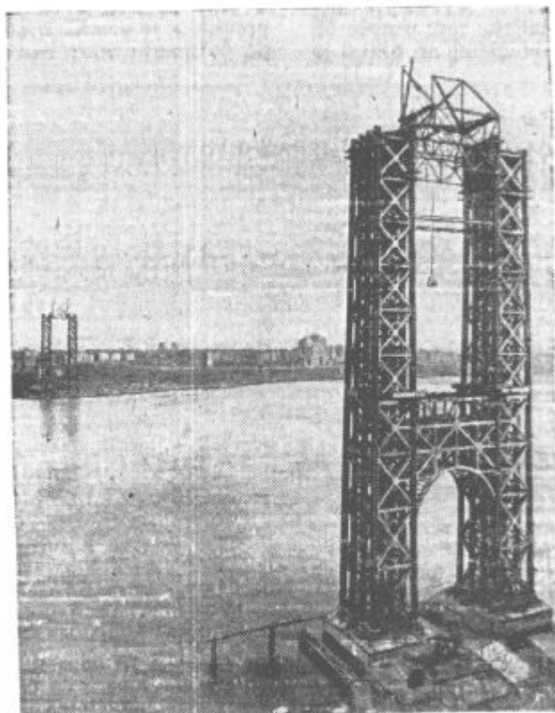
Montaža jeklenega ogrodja obeh nosilnih stolpov Hudsonskega mostu
