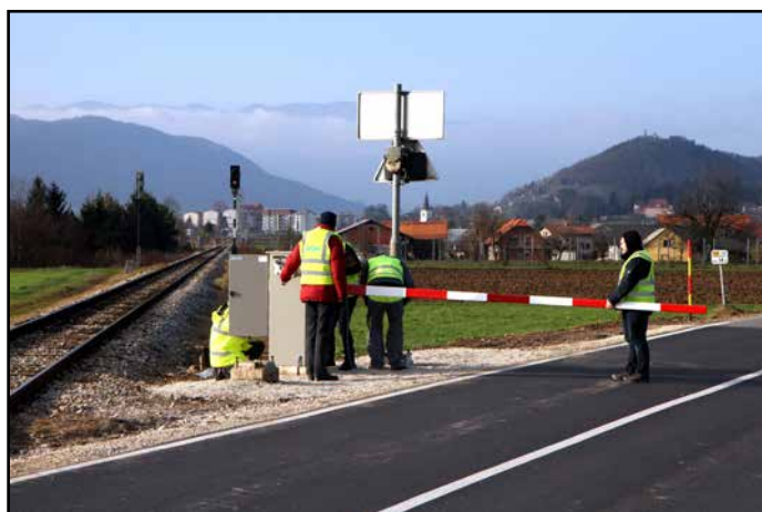
Na Bregu pri Polzeli so prehod čez železniško progo zavarovali z novimi polzapornicami.
