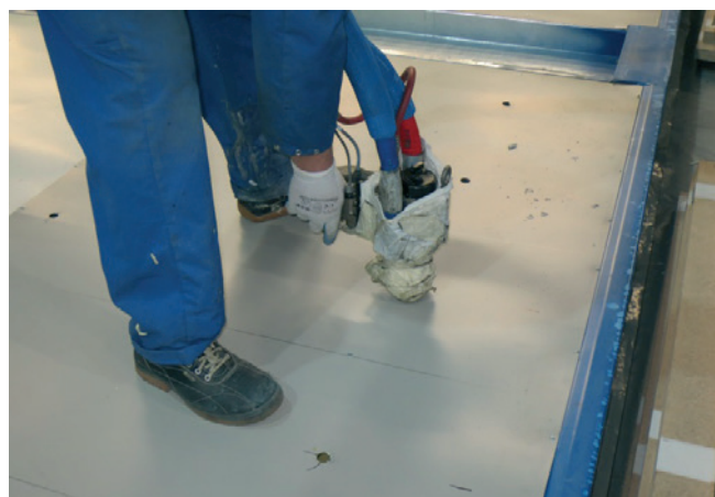
» Slika 4: Vlivanje poliuretana v pod modularne enote
