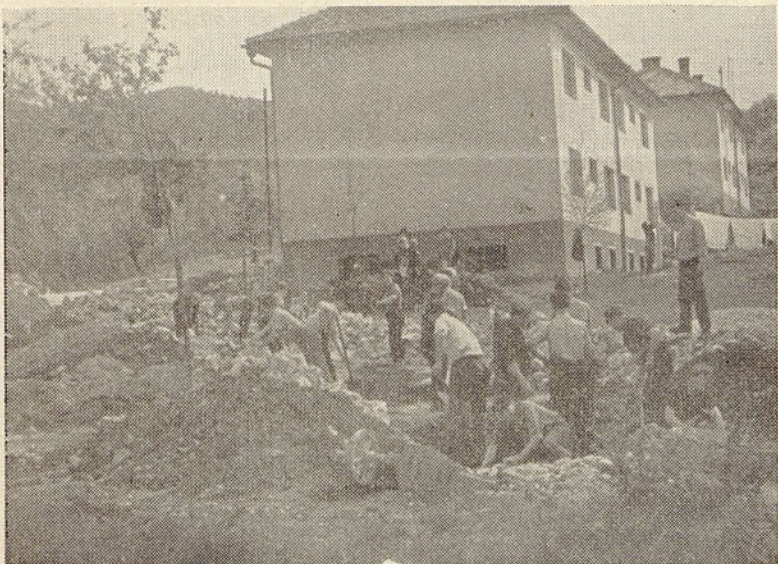
Začetna dela v naselju na Lipi
