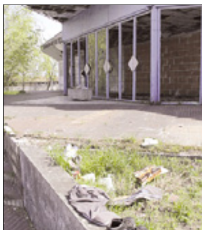
Degradirano območje nekdanjega diska
