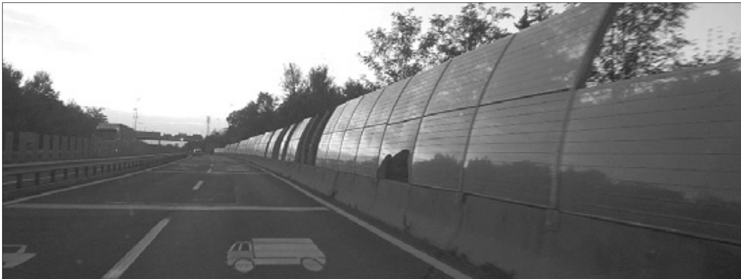
Poškodovana protivetrna zaščita na Bazari pri Šempetru
