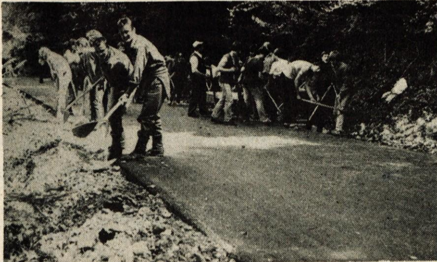
Jamnik - Z udarniškim delom je devdeset mladincev in nekaj krajanov iz štirih krajevnih skupnosti, ki jih povezuje nekdanja partizanska cesta pod obronki Jelovice-Krope, Podbluce, Selc in Dražgoš - v soboto urejevalo robove na novo asfaltirane ceste, izkopalvo mulde in koritnice. Do Jamnika je zdaj že potegnjen asfalt. Lep dan so imeli in veliko so naredili. Med mladina, katerih je bilo kar petdeset iz Krope, je bilo tudi deset pripadnikov JLA iz kasarne heroja Antona Dežmana iz Radovljice. Velika prizadevnost mladine in krajanov iz teh krajev pa je ta dan spravila k delu na cesti tudi vodilne delavce Cestnega podjetja Kranj, ki so svoj solidarnostni dan opravili pri asfaltiranju koritnic. - Foto: D. Dolenc
