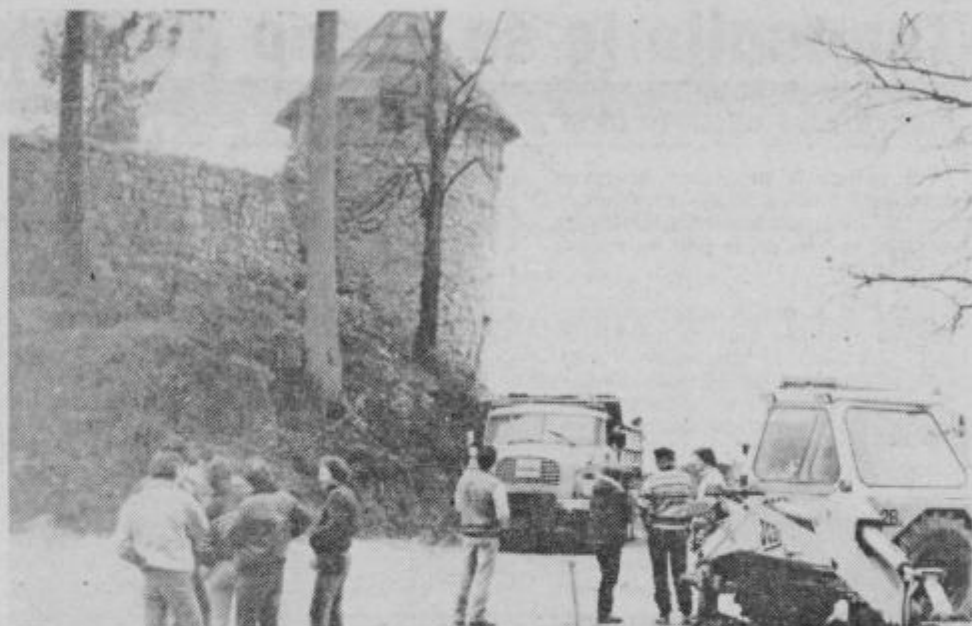
Obrambni stolp gradu Tabor v Laškem se je zaradi plitkih temeljev, nevarno nagnil proti dolini in zagrozil, da se bo porušil na bližnje hiše.
