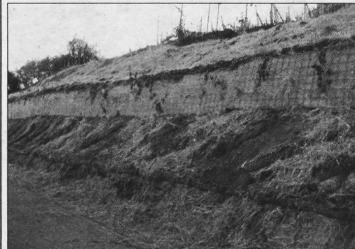
KORITNO - V Krajevni skupnosti Krško se bo v tem tednu začela sanacija brežine v Koritnem, pod stanovanjsko hišo Glas. Zgrajen bo kamniti oporni zid v dolžini 35 metrov, ki bo zaščitil brežino pod stanovanjskim objektom in omogočil boljšo prevoznost ceste. V času sanacije, ta bo predvidoma potekala 3 tedne, bo odsek Glas-Šoba zaprt za ves promet. Obvoz bo urejen.
