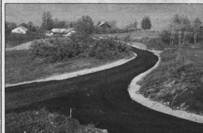
MODERNIZIRAN ODSEK ZDOLE-RAVNE - Občina Krško je v niz letos moderniziranih cest priključila tudi odsek Zdole-Ravne, kjer je obnovila del poškodovanega cestišča in modernizirala preostanek. Zamenjan je tampon, urejeno je odvodnjavanje ter položen osnovni asfalt v širini 3,5 m. Posodobitev je vredna 2,5 mio tolarjev.
