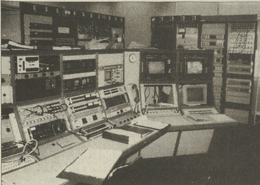
Glavna razdelilnica v prisluškovalnem središču v Crowsley Parku. Semkaj se steka vseh 128 signalov z najrazličnejših satelitskih in kratkovalovnih anten
