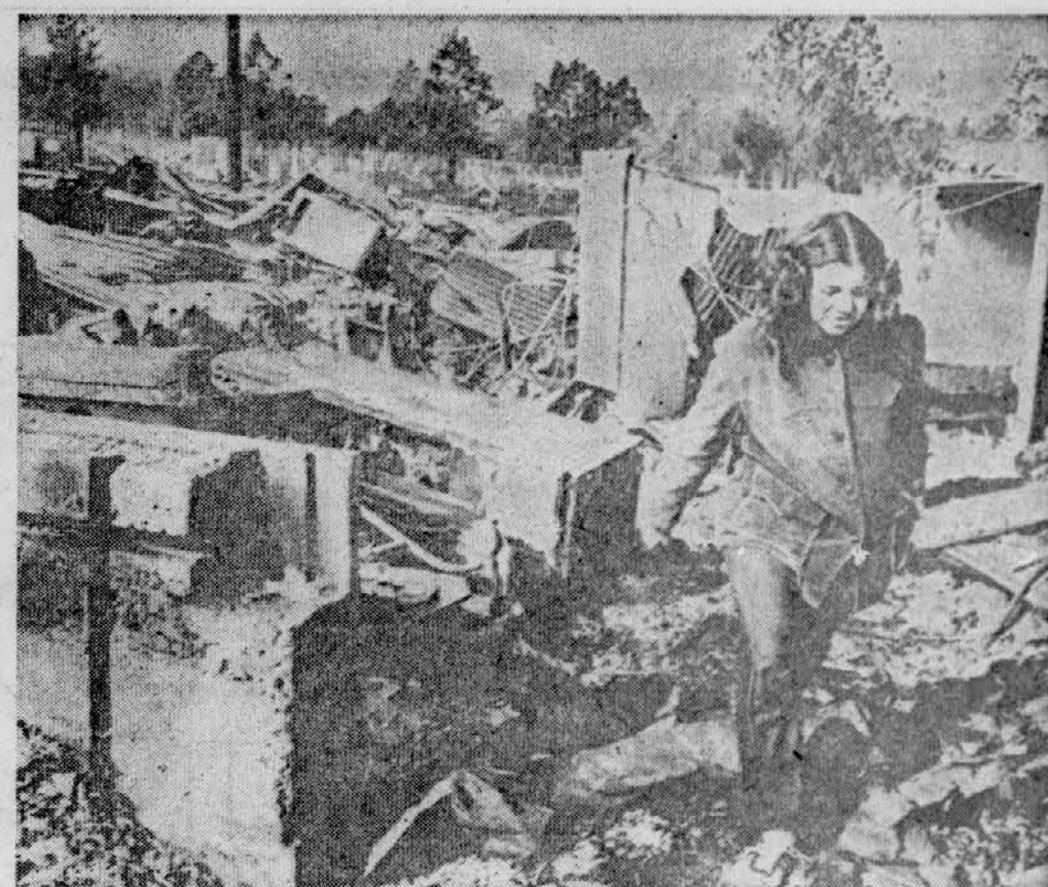
GOZDNI POŽAR UNIČIL SOLO — V ameriški državi New Mexico je izbruhnil silovit gozdni požar, ki bi skoraj uničil zaščitene gozdove Lincolnovega nacionalnega gozdnega parka. Medtem ko se je 500 gasilcev borilo s požarom takorekoč iz oči v oči, so letala bombardirala plamen s posebno peno. Požar je docela uničil tudi neko šolo na tem območju. Telefoto: UPI
