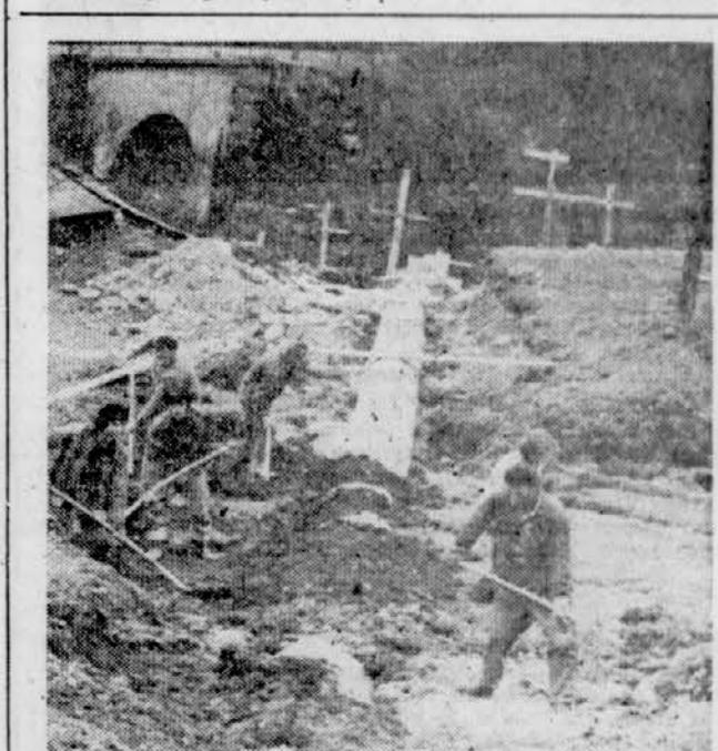
KMALU NOVA KANALIZACIJA — V novem jugovzhodnem delu Koroške Bele delavci jeseniškega podjetja »Kovinar« novo kanalizacijo, po kateri bo odtekal voda s precej lonavneja in močvirnaterega terena. Denar je prispevala občinska skupščina Jesenice.
