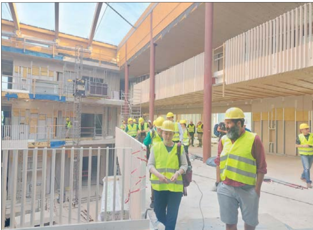
Slika 5: Ogled gradnje šole in vrtca (foto: K. Sever)
