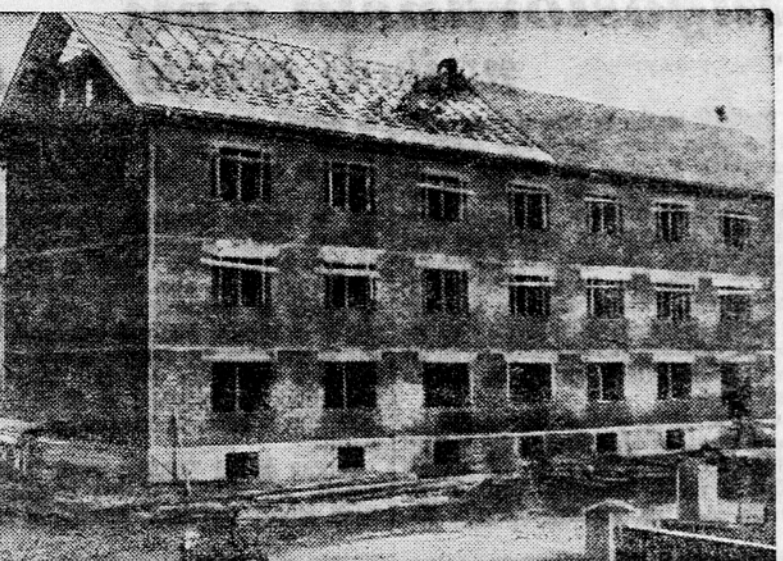
V nedeljo 21. t. m. so frontovci 18. terena v Šiški zmagoslavno pokrili svojo stanovanjsko stavbo, v kateri bo našo stanovanje 12 družin. Stavba, ki je zgrajena skoraj popolnoma s prostovoljnimi delom, je zdaj pod streho. S tem pa je končana seveda šele prva polovica tega velikega dela. Izmed vseh frontovcev, ki so stavbo gradili z največjim požitvnanjem, so se najbolj odklikovali tovarishi: Rojč Ivan, Nebec Franc star., Poljanec Drago, Zupančič Herman, Mramor Ludvik, Černe Jule, Dermaša Ignac, Piš Dušan, Gruden Marija, Omejec Marija, Makovec Franc, Vernik Stane, Juhant Franc in Bitenc Tončka. Vsi ti so zrtvovali od 500 do 900 narnornih prostovoljnih delovnih ur in serbeli tudi za organizacijo dela. Zato je predvsem njihova zasluga, da je stavba danes pod streho.
