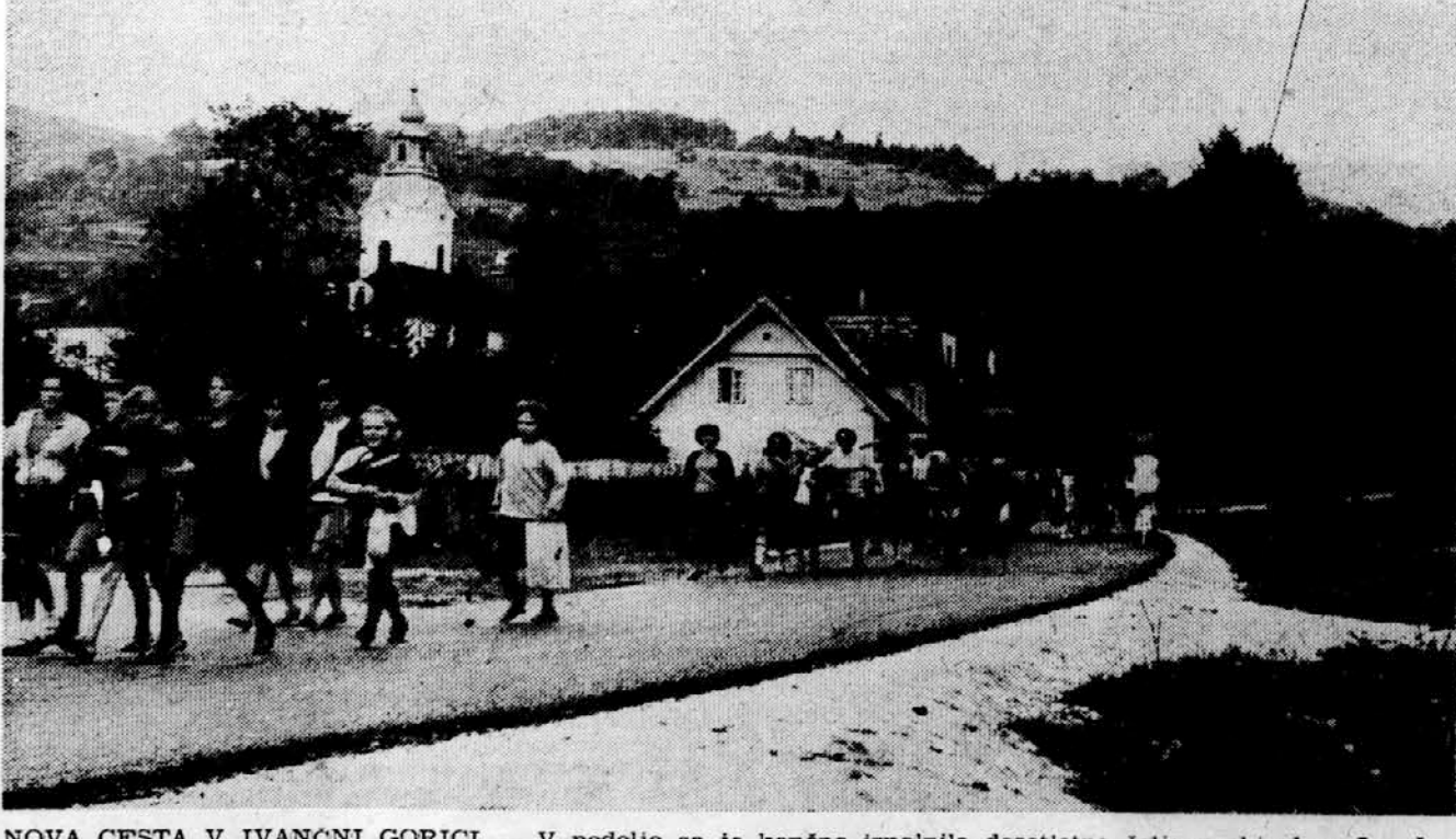
NOVA CESTA V IVANČNI GORICI — V nedeljo se je končno izpolnila desetletna želja prebivalcev Ivančne gorice, da so dobili asfaltirano cesto, ki pelje v Stično. Prahu in blata se imeli že dovolj, zato sta krajevni skupnosti Ivančna gorica in Stična sklenili, da mora biti ta cesta še letos urejena in sposobna za sodoben promet ...
