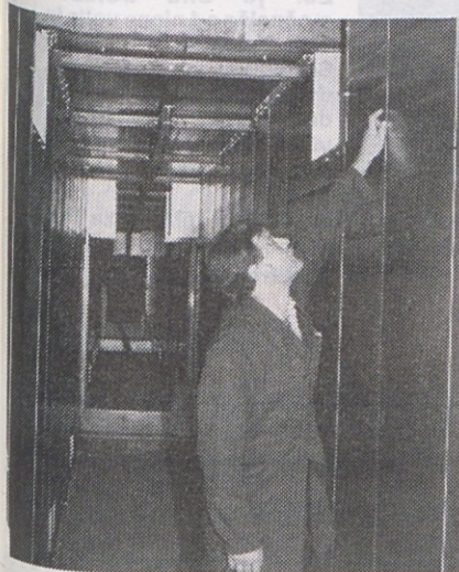
2. avgusta montaža opreme sušilnika peči
