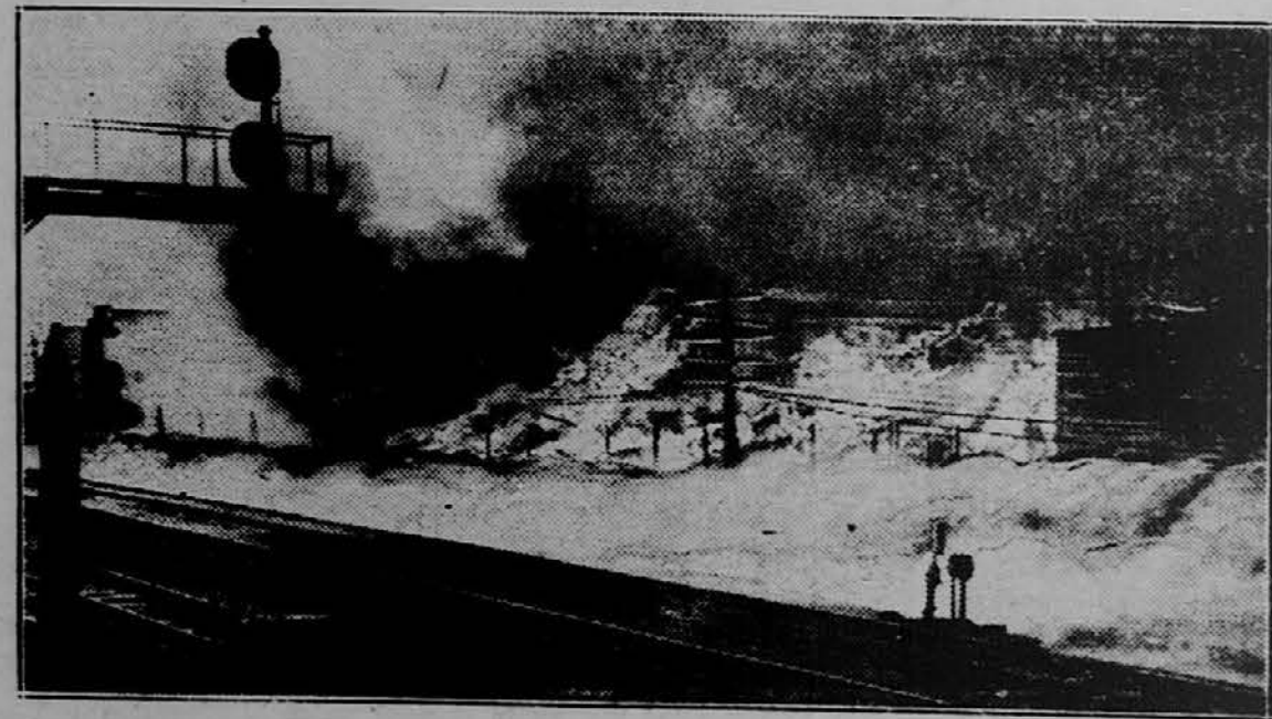
Pred kratkim je izbruhnil požar v veliki tovarni za plutovino v Lyndhurst, N. J. Zgorla so štiri velika skladišča. Povzročena škoda znaša pol milijona dolarjev.
