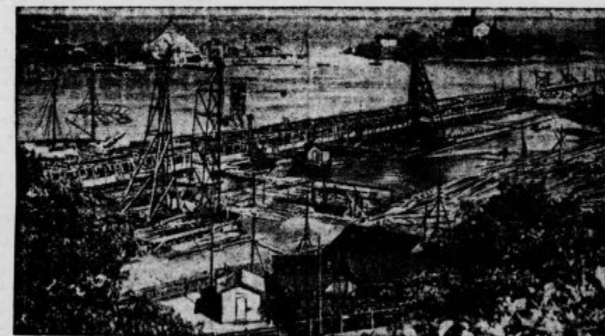
Pristanišče v Helsinkih.
