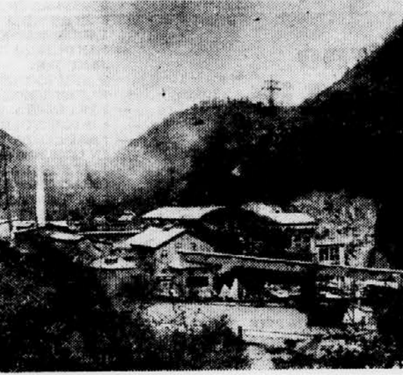
Cementarna. Pogled na cementarno v fazi rekonstrukcije.
