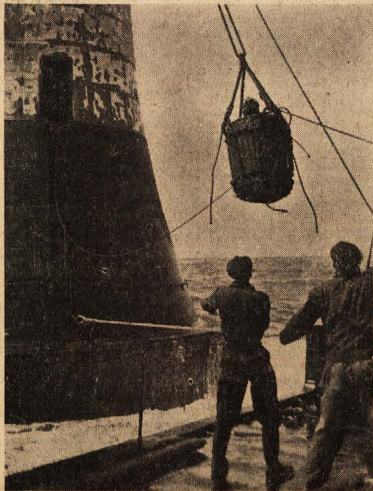
Ob izlivu Wesere v Severno morje stoji že 70 let najstarejši nemški svetilnik, ki so ga nedavno pregledali in ugotovili, da ga bo treba podreti, ker so železni sestavni deli stolpa že močno zarjaveli, in na istem mestu zgraditi novega. Posnetek kaže, kako v košu izmenjujejo posadko.
