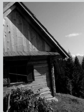
□ Slika 6. Streha iz skodel ščiti horizontalni tram pred padavinami
