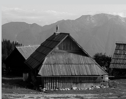
□ Slika 10. Zaščita lesene zgradbe na izpostavljeni severni strani z vertikalno postavljenimi skodlami in deskami
