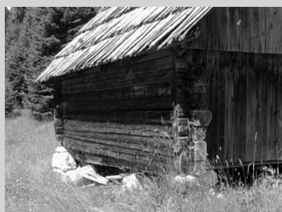
□ Slika 8. Kamnito podnožje lesenega zidu preprečuje dvig kapilarne vlage, kar ščiti leseno steno pred gnitjem
