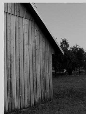
□ Slika 7. Na vertikalno postavljene letve na fasadi voda hitreje zdrse kot na horizontalnih letvah
