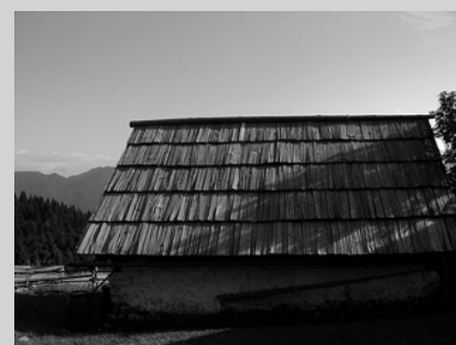
□ Slika 2. Strma streha iz skodel - voda v smeri vlaken hitro odteče
