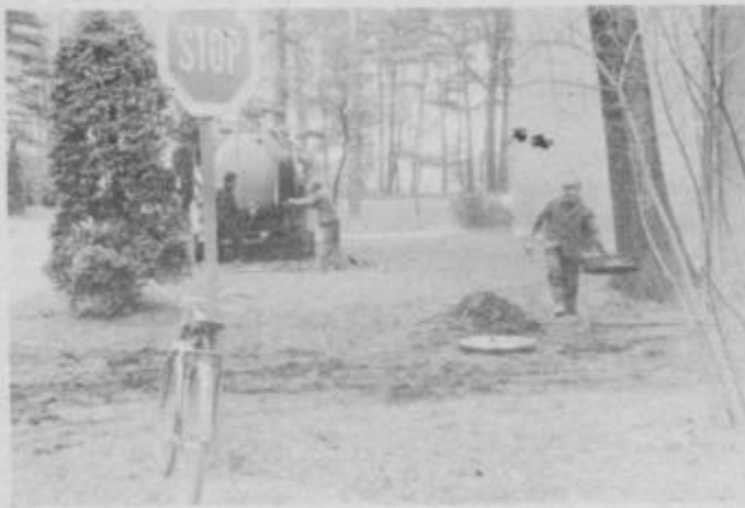
Delavci ptujske komunale pri čiščenju kanalizacije v Kidričevem
