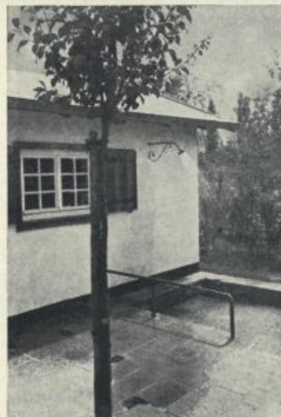
Zunanja prša z majhno vodno kotlino in vodovodom.
