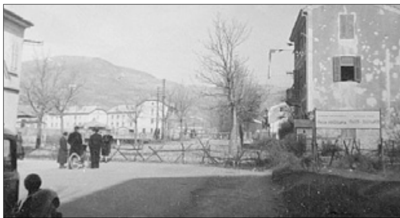
Mejni prehod na Erjavčevi
