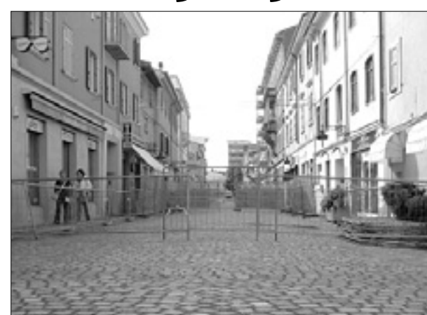
Gradbišče v Tržiču
