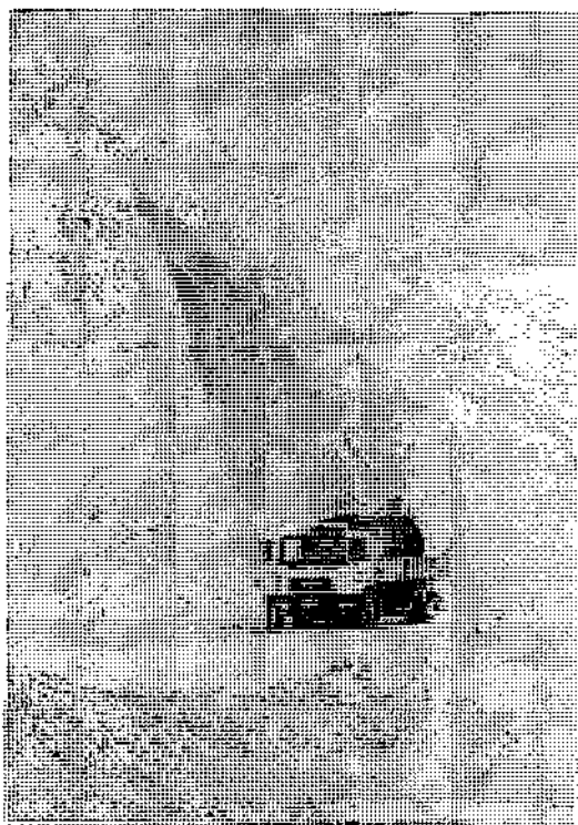
Rekultivacija kamnolomov: prebrizg stnkih kamnitih brežin z rastno pulpo (ekstremni nagibi). Cilj ukrepa je doseči delno ozelenitev na razpokanili površinali in poličkah, kjer se lahko zadrži rastni substrat, in na ta način razbiti nenaravno monotoniijo sterilnih kamnitih površin. (Foto: Lojze Rus)
