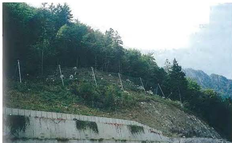
Slika 1: Zaščitni ukrepi pred padanjem skal ob AC Hrušica-Vrba: podajne loviline ograje (Foto: D. Durjava)
