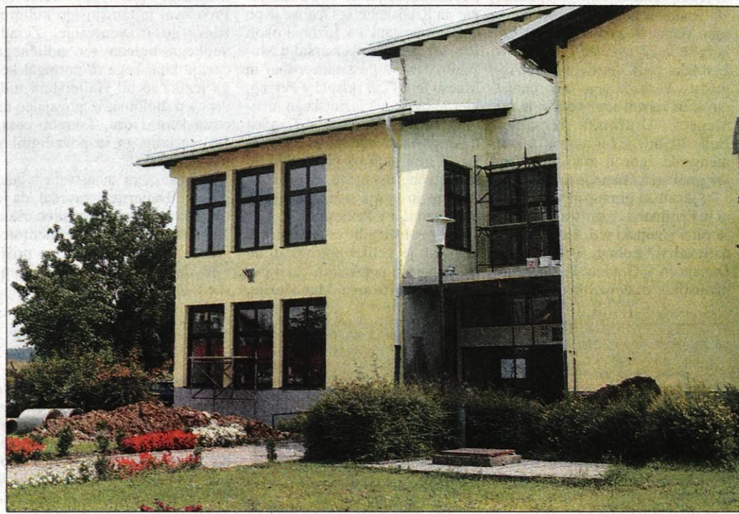
Ena največjih investicij je obnova šole in izgradnja prizidka.
