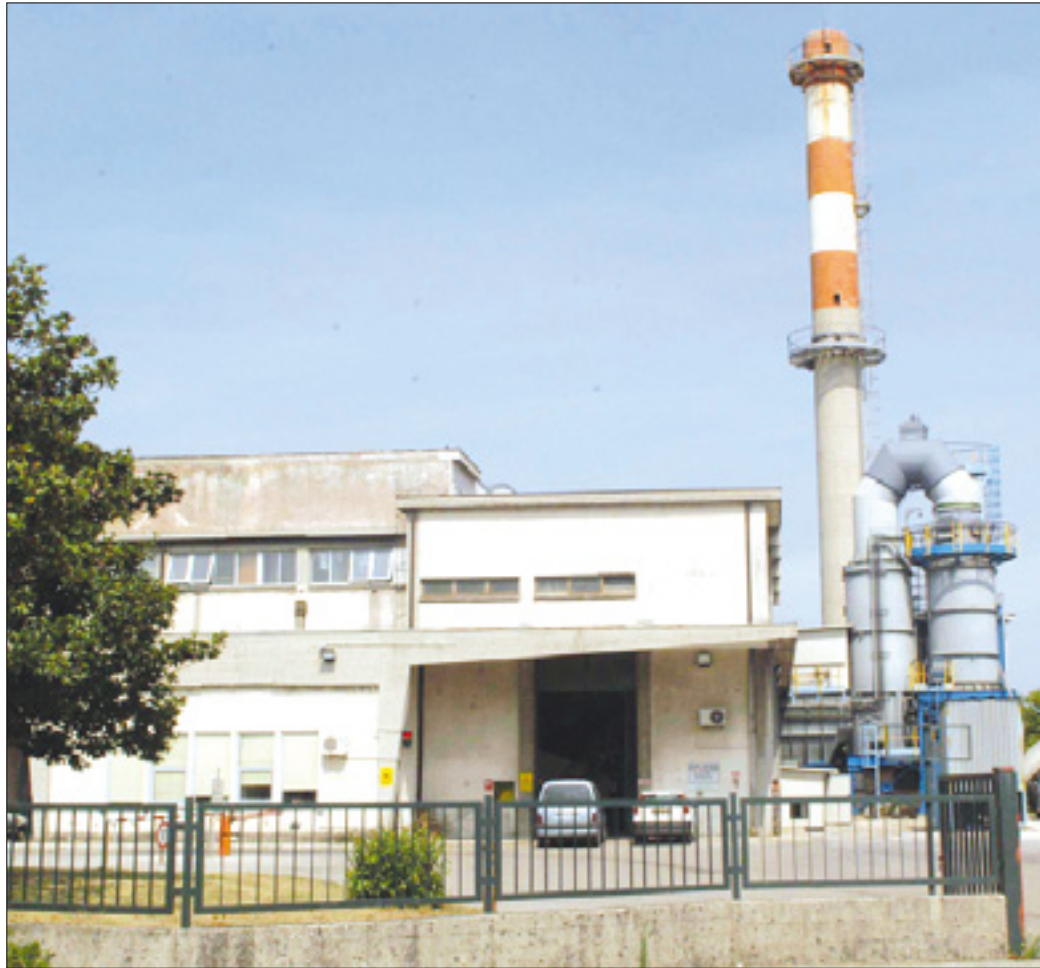
Opuščena goriška sežigalna naprava na meji s sovodenjsko občino
