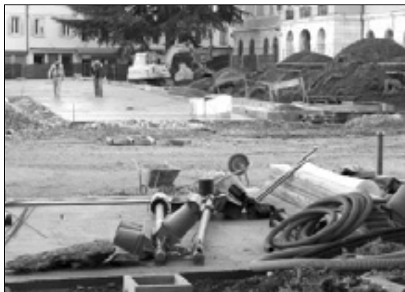
Gradbišče na Travniku
