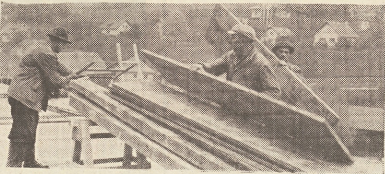
Opazne plošče morajo biti pripravljene. Le tako gre delo hitreje od rok
