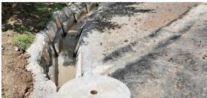
Sanacija ceste Šentožbolt - stara šola.
