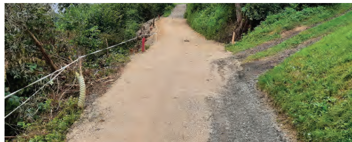
Sanacija plazu na cesti Spodnje Loke.
