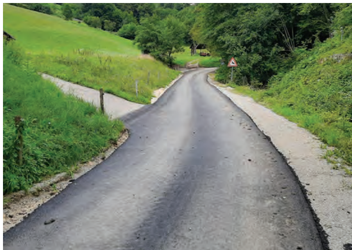
Sanacija odvodnjavanja na cesti Šentožbolt - Bršelnovica.
