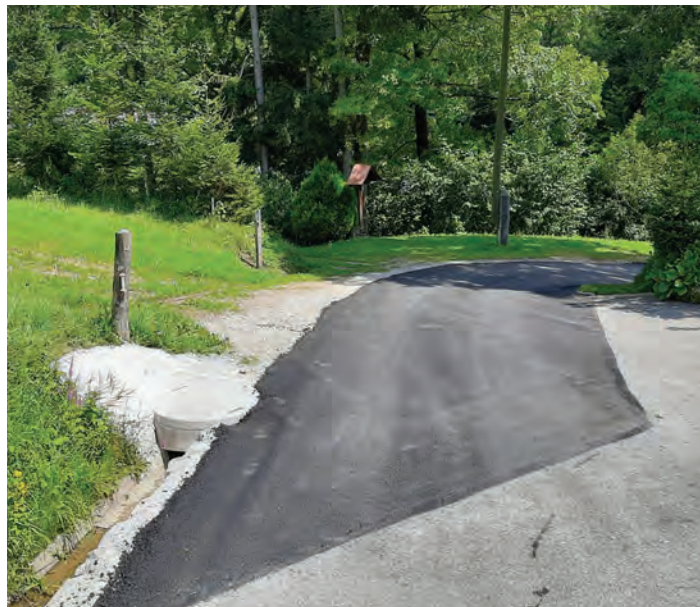
Sanacija plazov na cesti Spodnje Loke.
