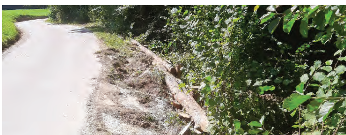
Pilotiranje brežine cesta Spodnji Petelinjek – Javorje.
