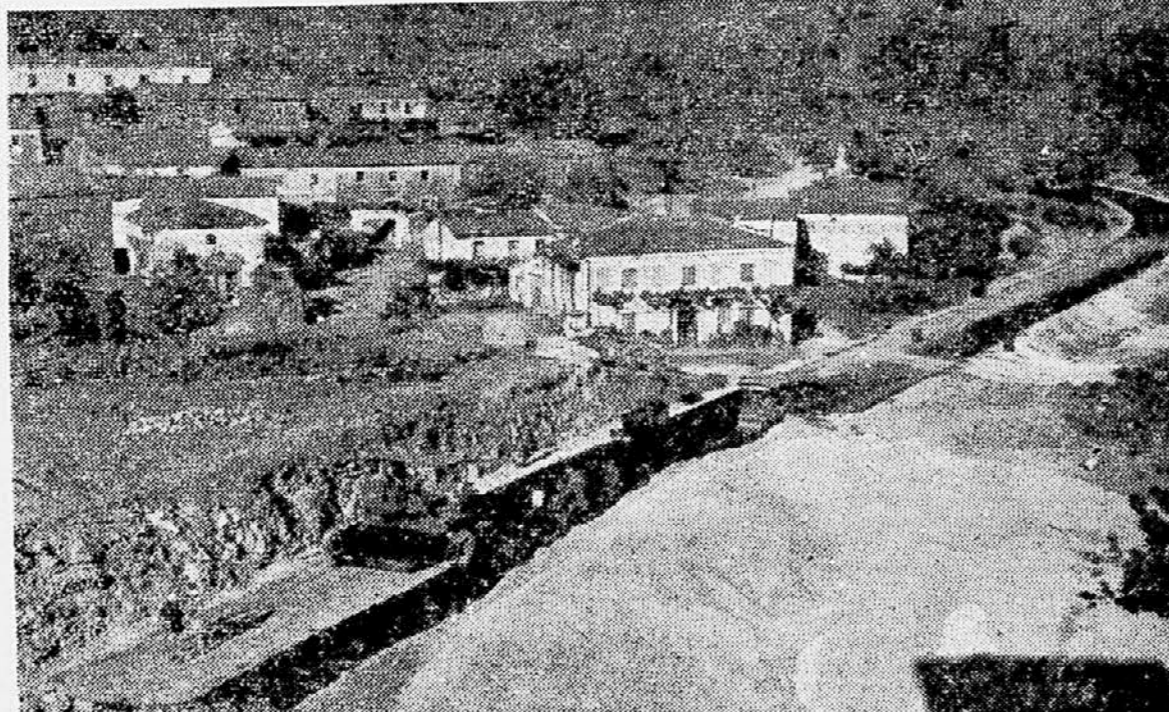
Se dober teden dni in koprška cesta bo v celoti izgotovljena. Na sliki pogled na znano vasico Petrinje in na zaključni del trase koprške ceste Petrinje-Kastelec, kjer asfalterji Slovenija ceste pravkar dokončujejo zadnja dela. Če bo vreme ugodno, bo kmalu stekel promet tudi po tem zadnjem odseku. - (Foto: Strnad)
