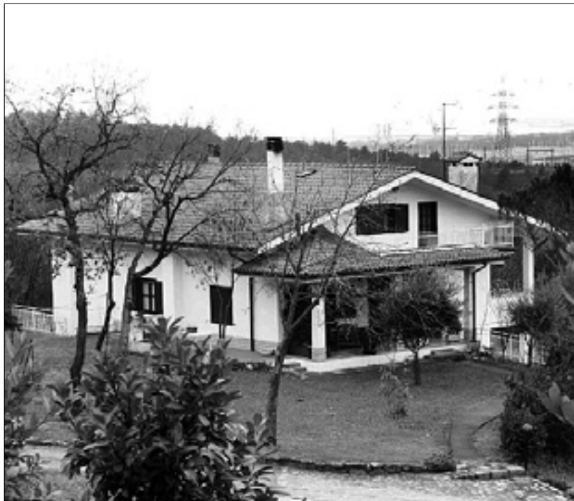
Najbolj ogrožena hiša pri Sabličih bo od železnice oddaljena 15 metrov
